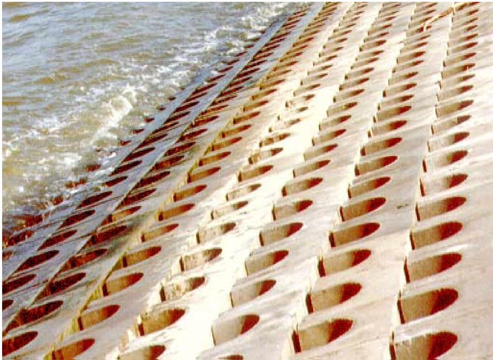
Hohldeckwerk an der Hafeneinfahrt Baltrum/Nordsee.
